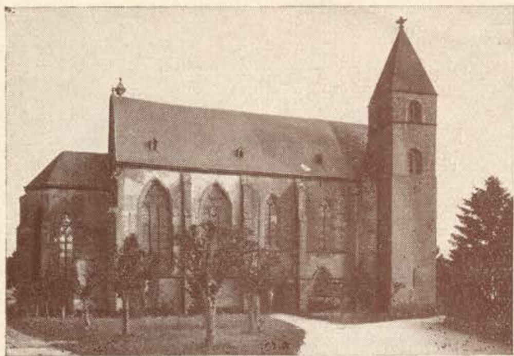
Stiftskirche mit Kreuzgang und Kapitelhaus, erbaut 1276 von Erzbischof Heinrich von Vinstingen, ein Baudenkmal gotischer Kunst
